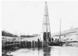
Wbijanie żelaznej ścianki Larsena w osi zapory w Żurze 24.04.1929 r.
