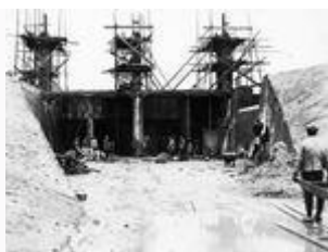
Budowa zamka wodnego w El. Żur 13.12.1929 r.
