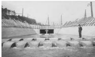
Upust głębinowy - skierowanie wód Wdy w celu budowy zapory 6.1929 r.
