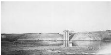
Budowa zapory w Gródku - widoczny wał z filarem zasuw, które obecnie są pod wodą. 29.11.1920 r.
