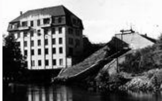
Elektrownia Gródek - widok na halę maszyn i służę tratew od dolnej wody
