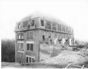
Prace wykończeniowe budynku hali maszyn w Gródku. 12.03.1923 r.
